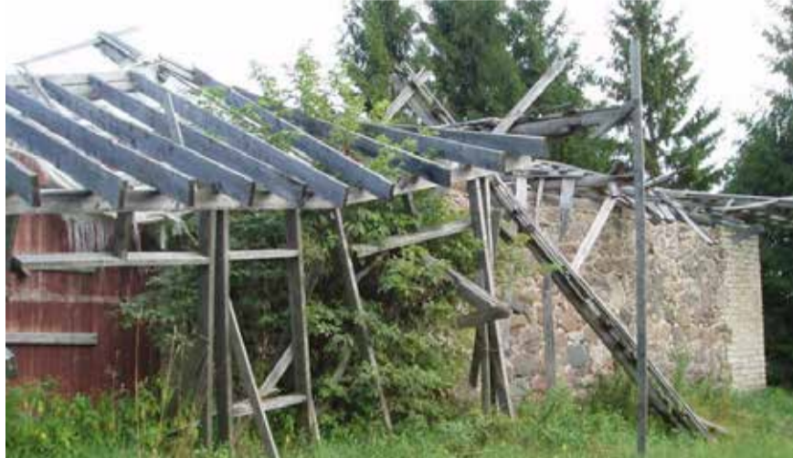
Kostifer enne rekonstrueerimistööd.
